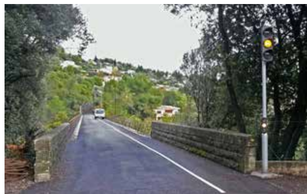
Voie unique contrôlée par feux intelligents et passage piéton
