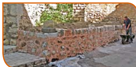
Réfection des murs autour de l'église
